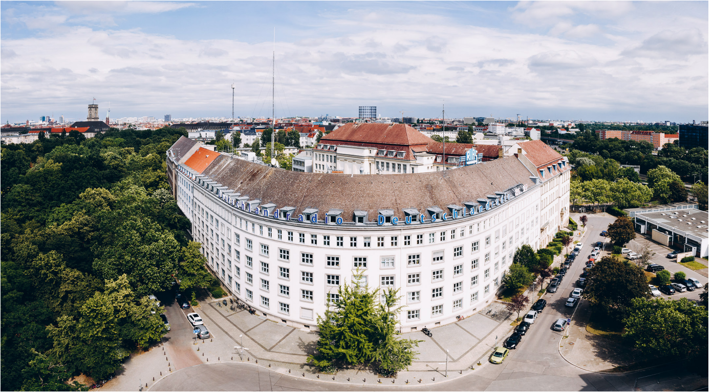
Außenansichten der Deutschlandradio-Funkhäuser (links: Berlin, rechts: Köln, © Deutschlandradio/Simon Detel)
