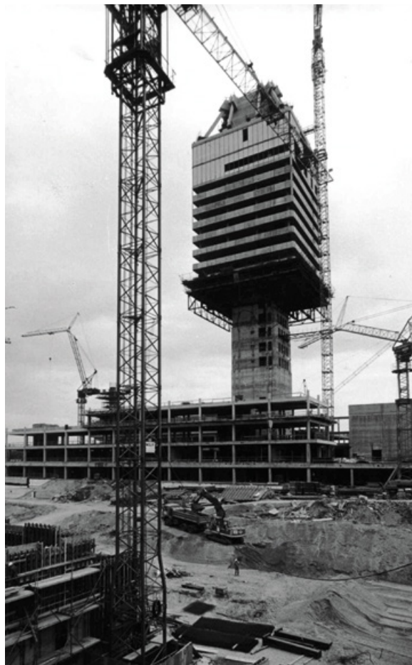
Im Rohbau: das Deutschlandfunk-Gebäude in Köln Mitte der 70er-Jahre
